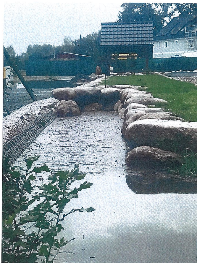
Przepust na rowie nr 39
