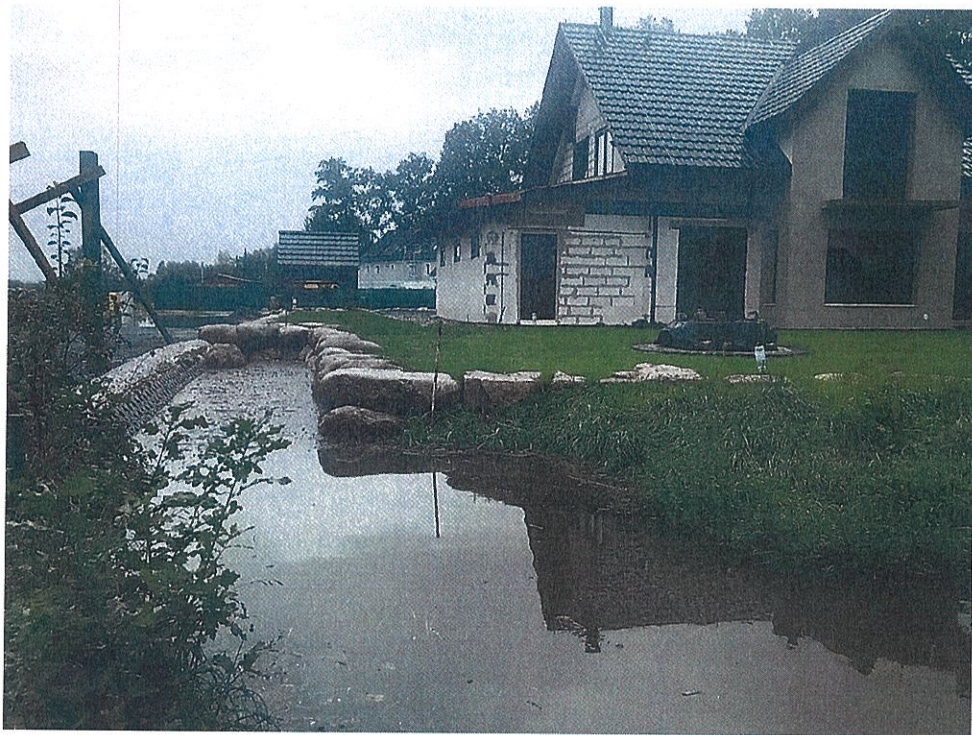
Przepust na rowie nr 39 i podwyższony grunt na terenie działek nr 25 i 26 (obręb 0060,60)
